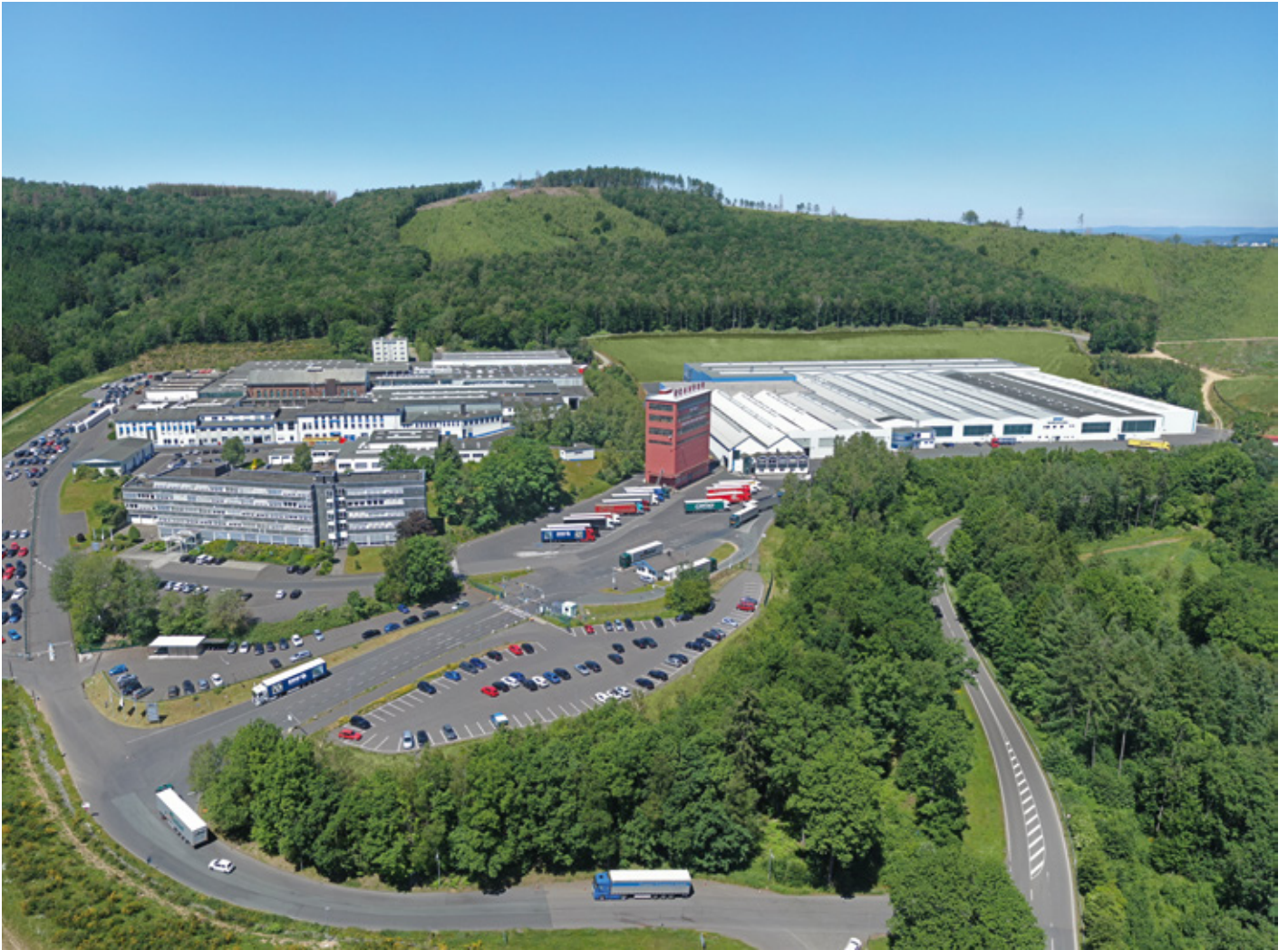
Hauptverwaltung und Werk Neunkirchen, Deutschland
