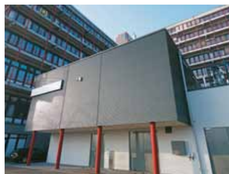
Das neue 450 m 2 große „New Data Center“ der Universität Siegen
